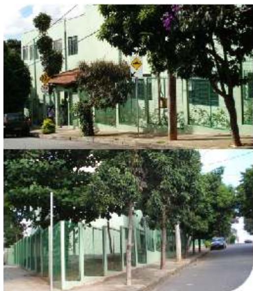
Fotos externas da creche reformada.
